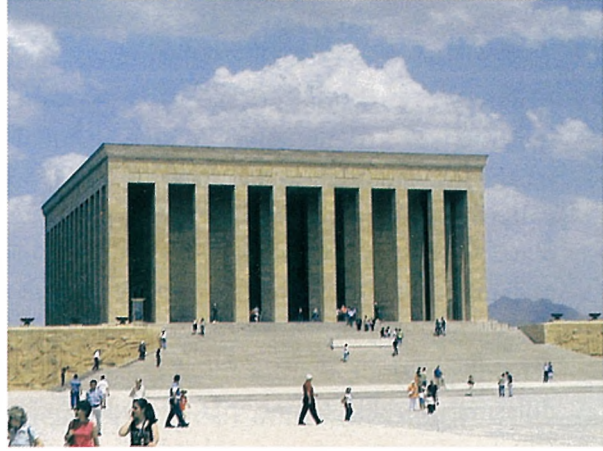
Travertenlerin kaplama taşı olarak kullanıldığı Anıtkabir'den bir görünüm
